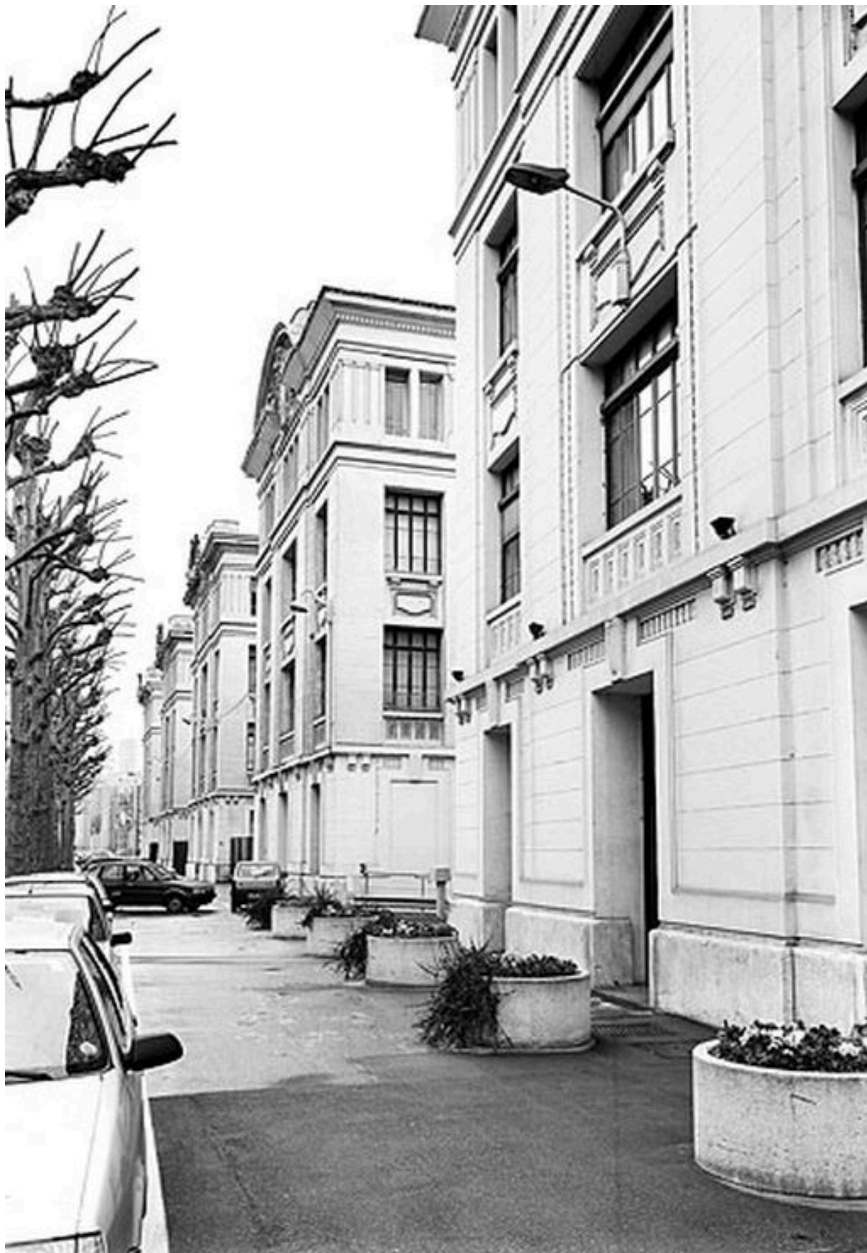
Vue partielle des pavillons en enfilade
