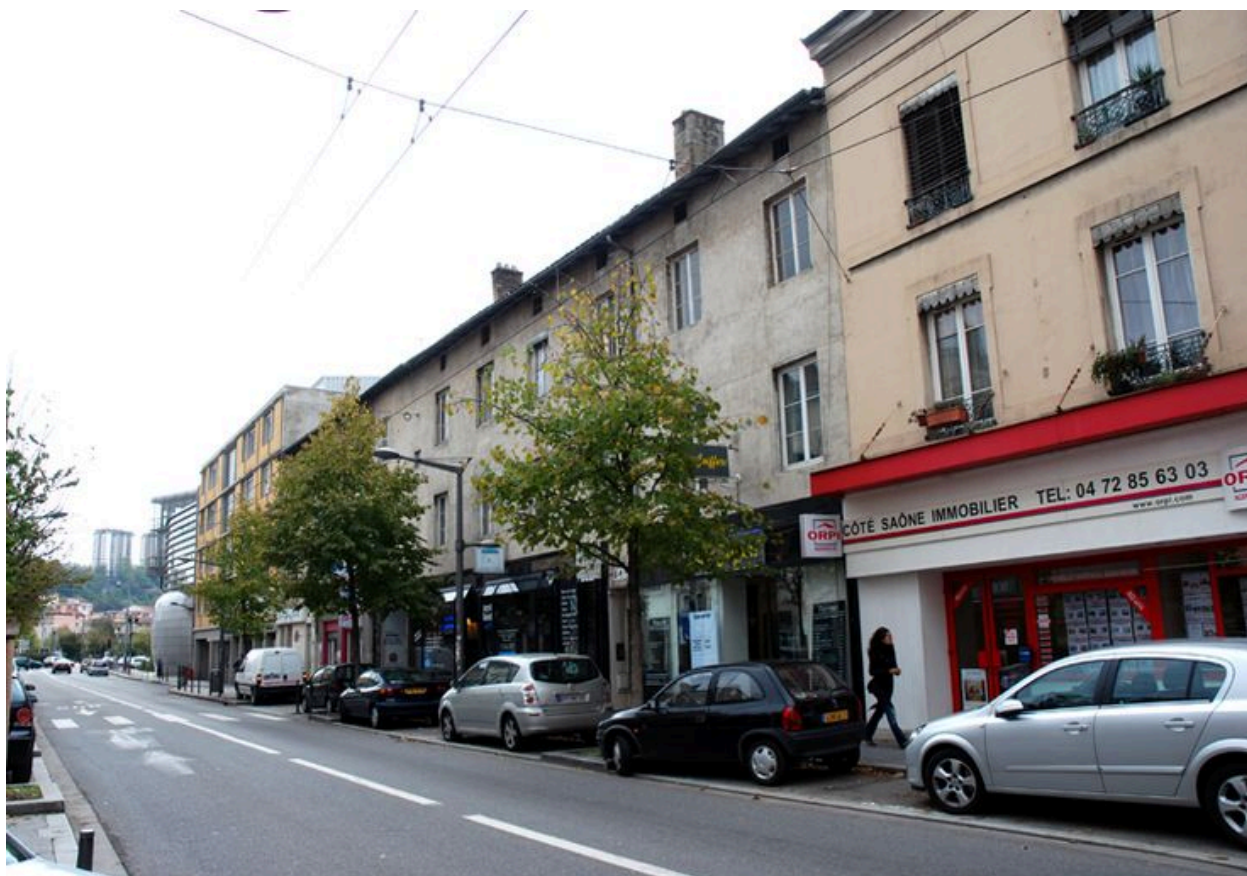
Vue générale depuis le nord
