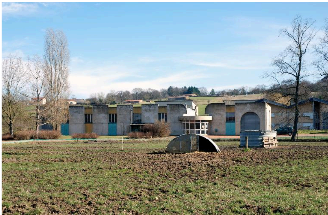
Bâtiment U (bâtiment d'exploitation), depuis l'ouest
