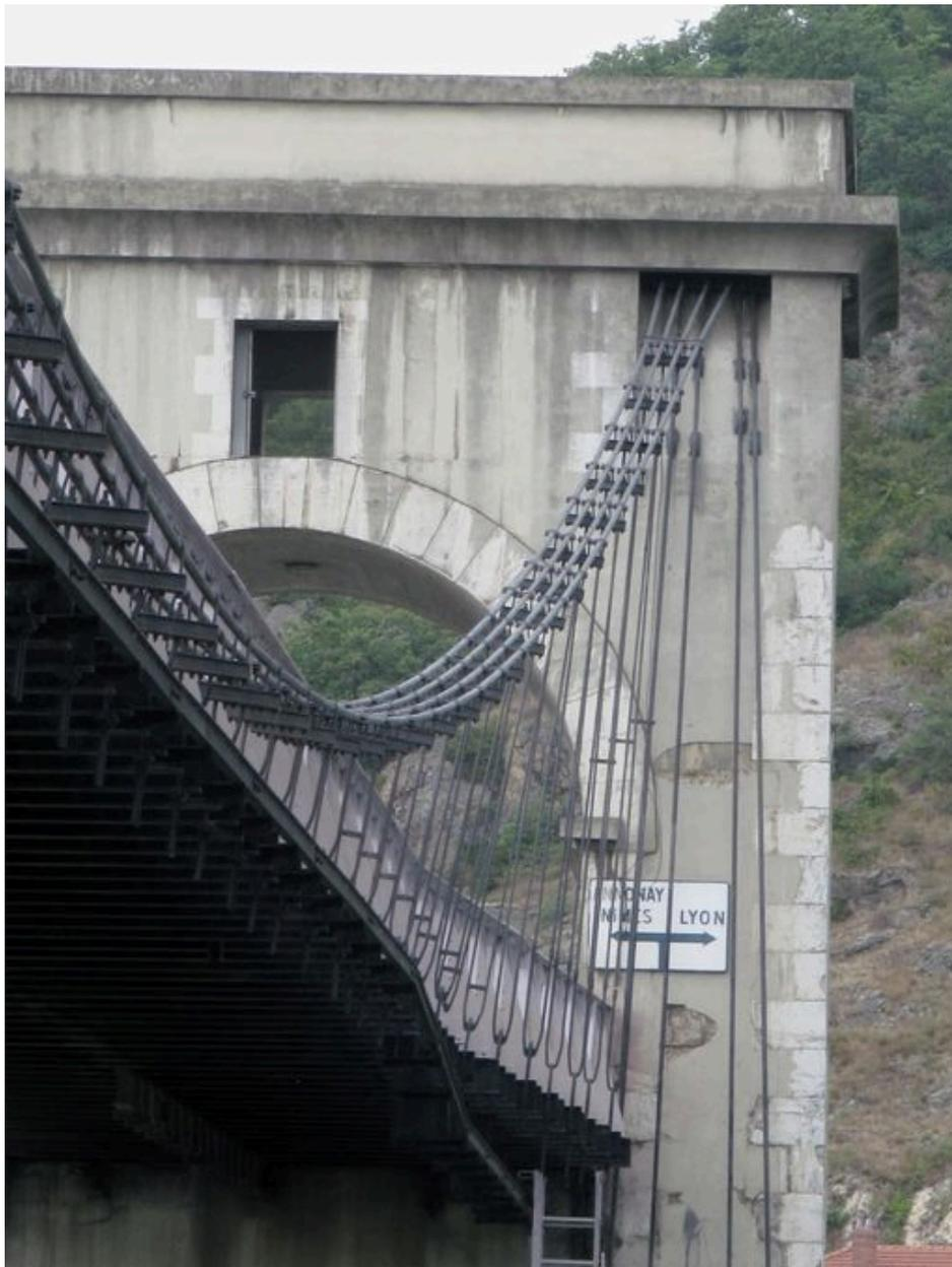
Pile centrale, face amont, vue partielle : ancrage du câble porteur et dessous du tablier (depuis la rive gauche)
