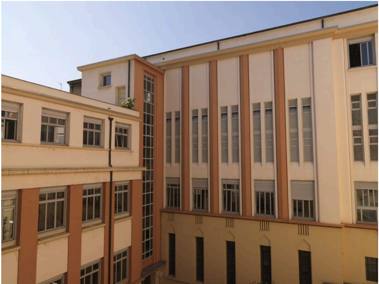
Cour intérieure, angle sud-ouest, partie supérieure
