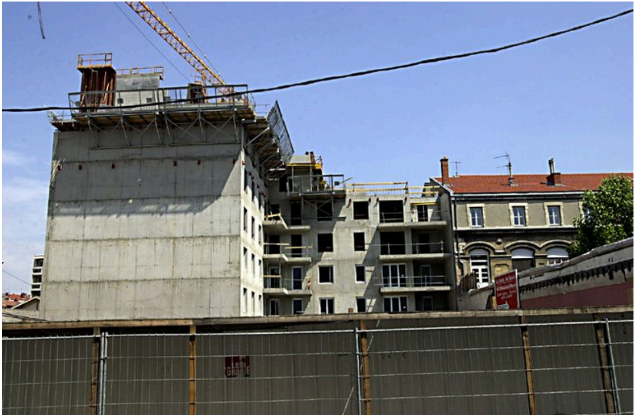
Immeuble en construction, côté rue du Béguin
