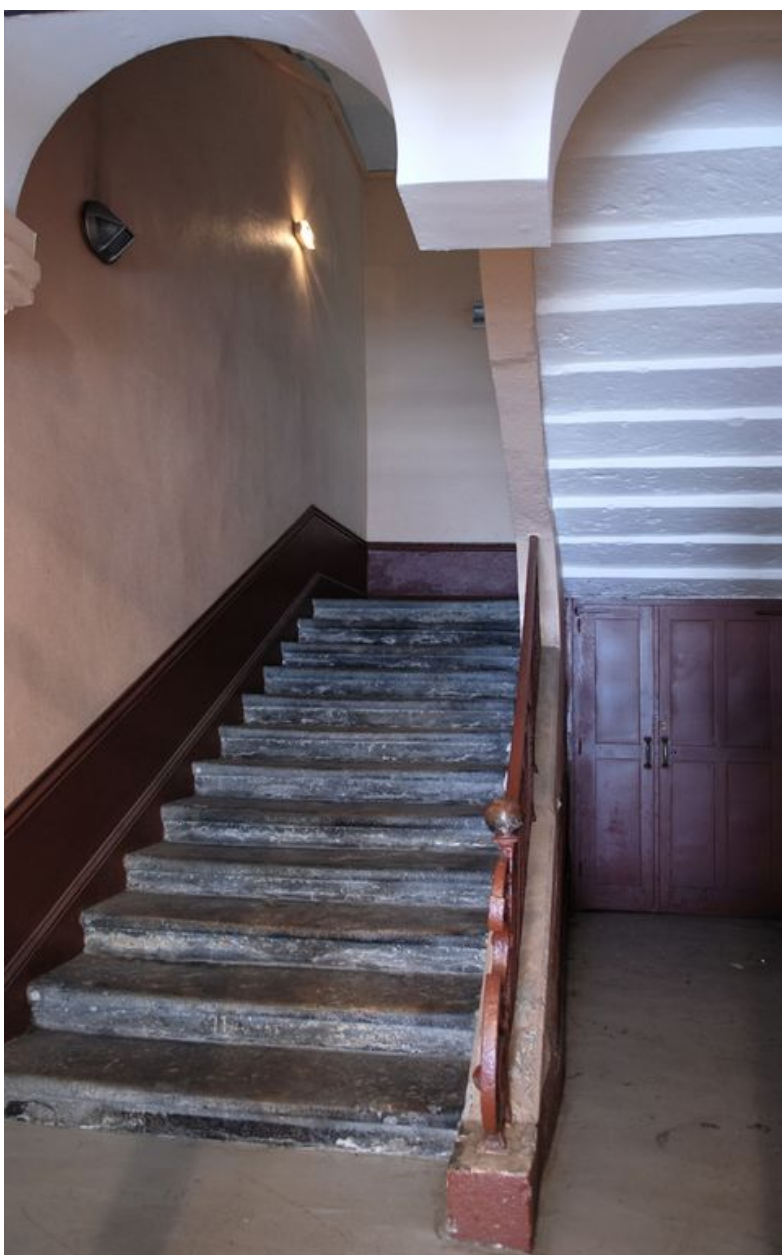
Vue de la première volée de l'escalier
