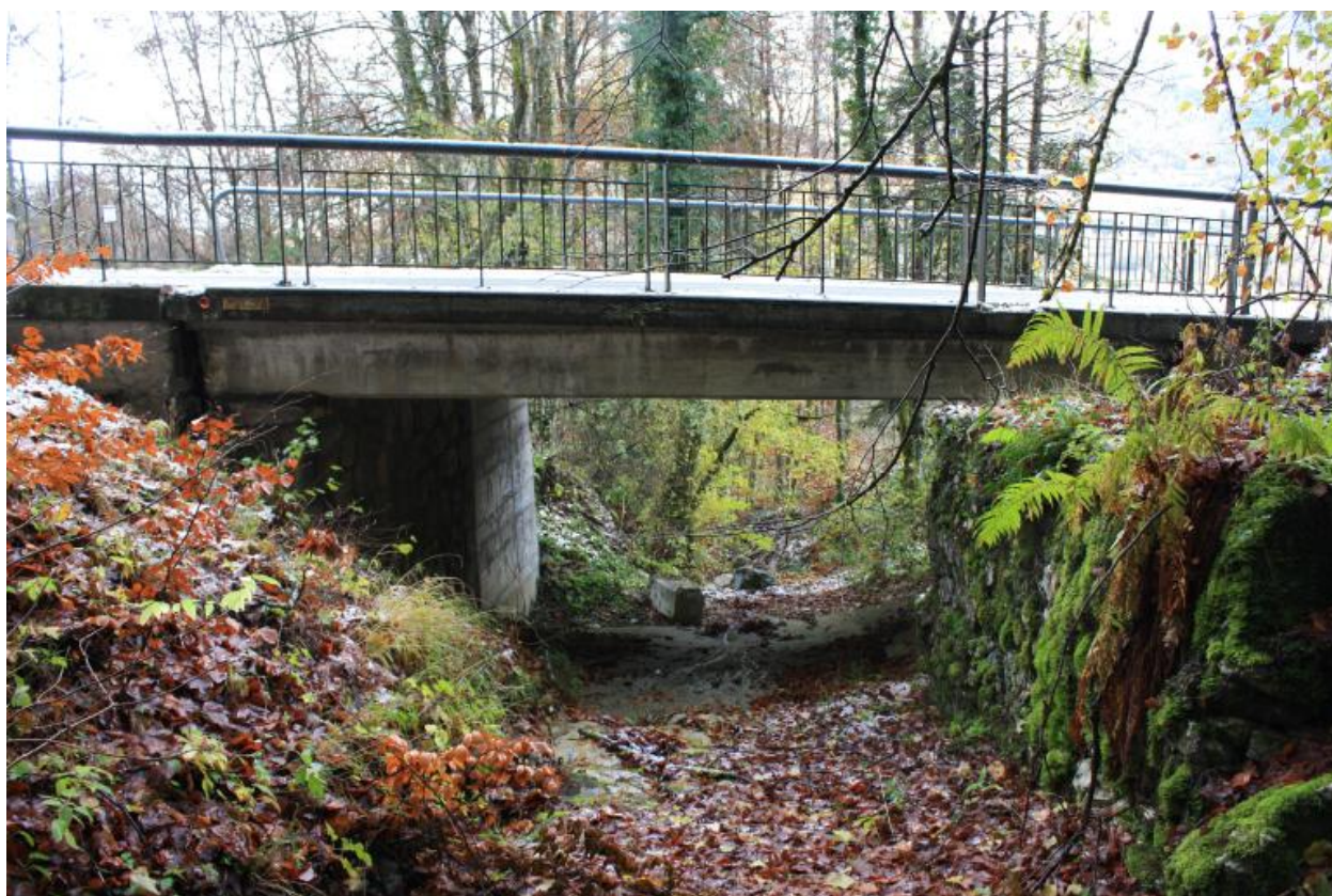
Pont de la Vernaz, face amont
