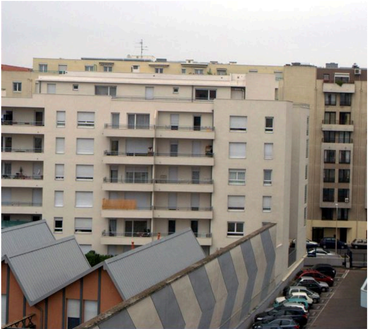
Élévation postérieure, vue partielle depuis l'est
