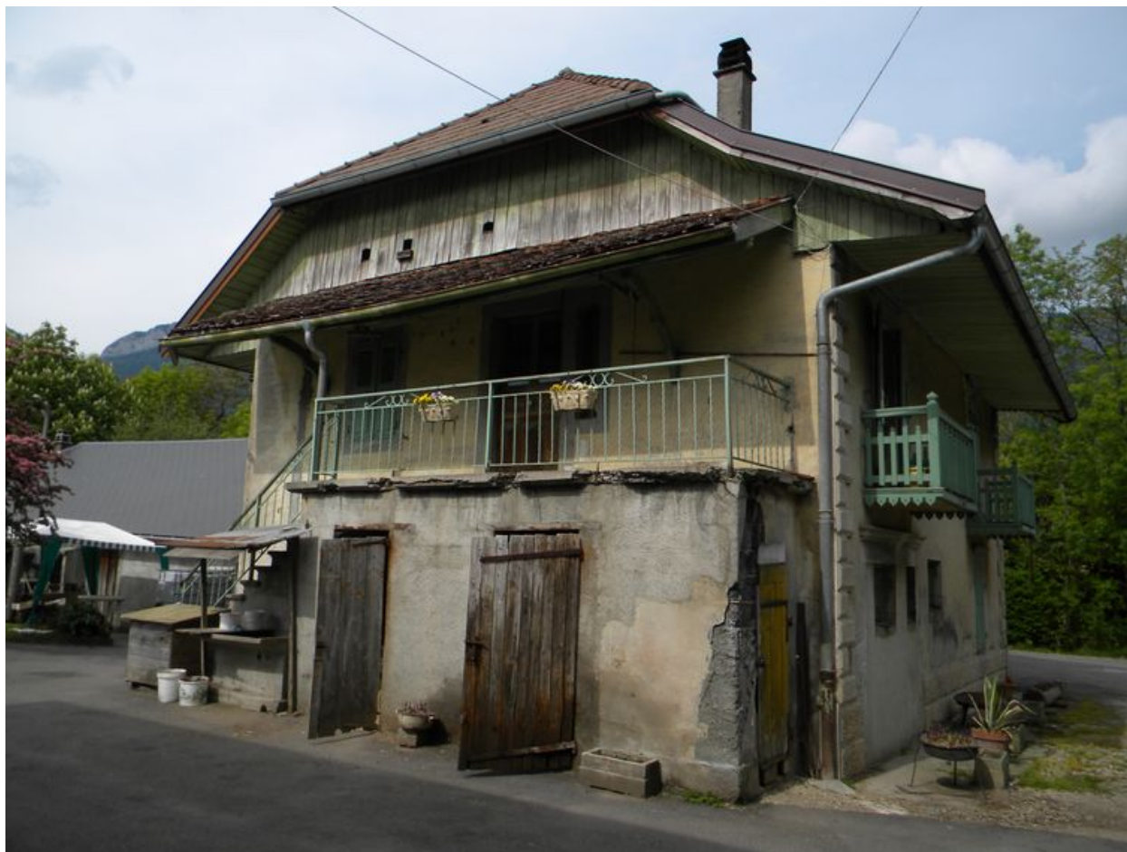
Façade arrière d'une habitation de ferme à l'architecture éclectique (B7 821).
