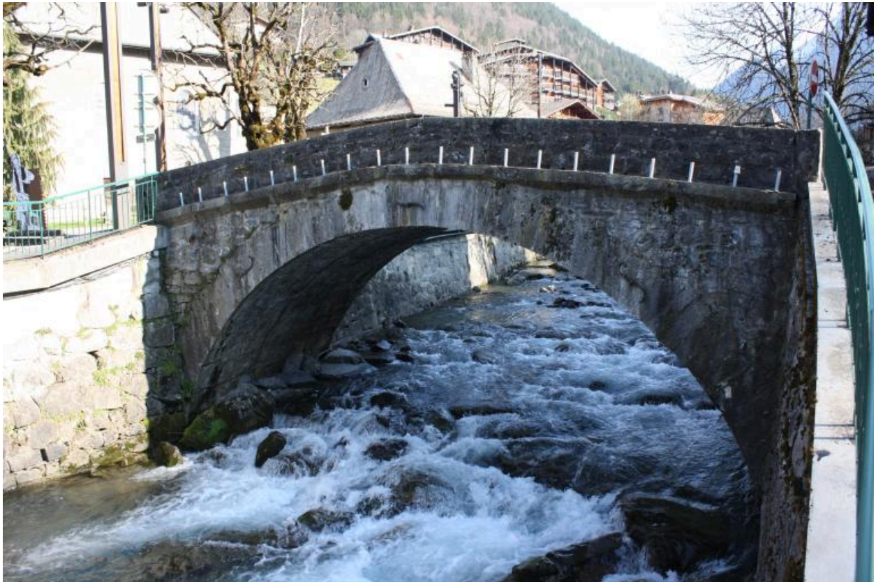
Vieux pont de Morzine, face aval
