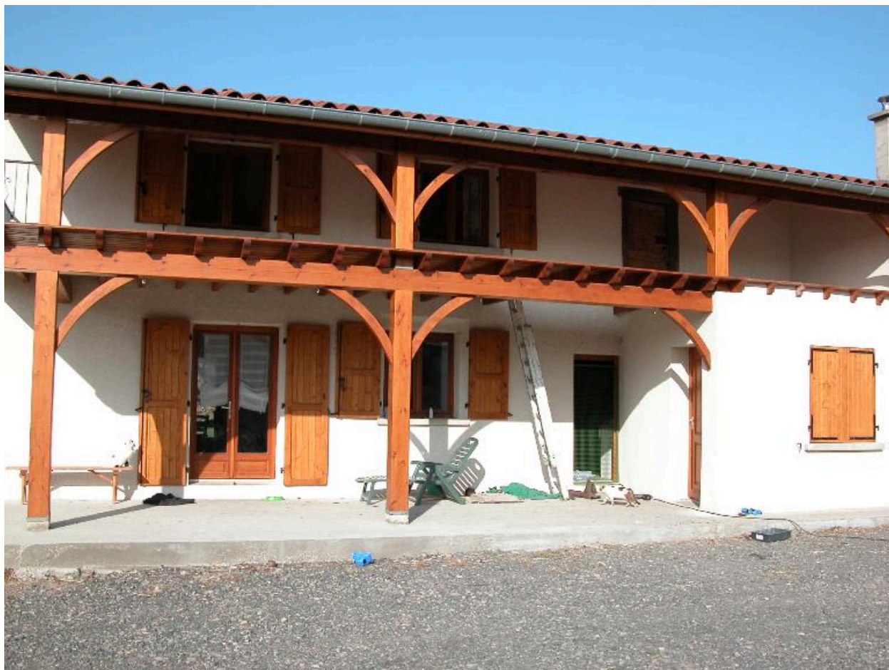
Vue partielle du logis.
