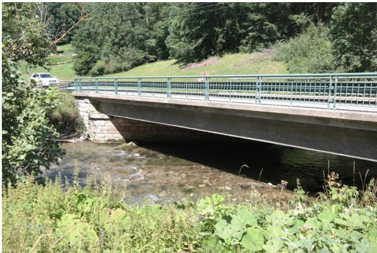
Pont des Portes, vue de la face aval
