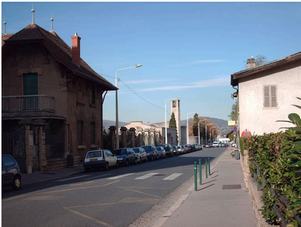
Vue générale depuis la rue Philippe-de-Lassalle
