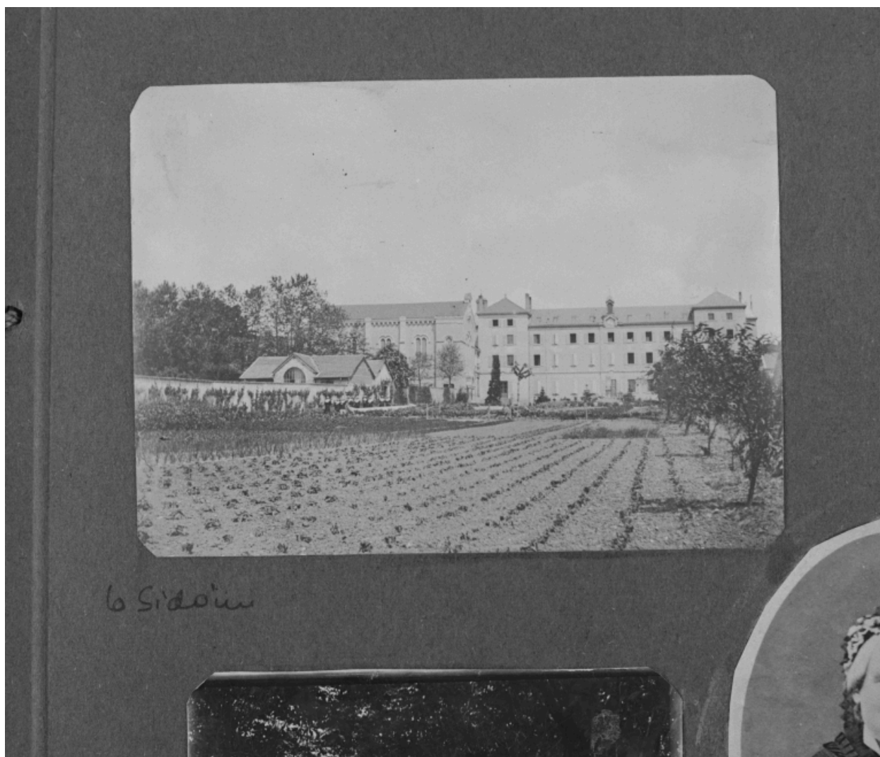
La Sidoine. Vue d'ensemble depuis le jardin potager. Photogr. [début XXe siècle].
