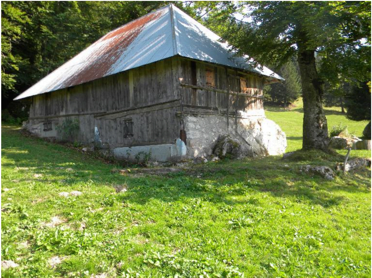
Vue de la façade arrière.
