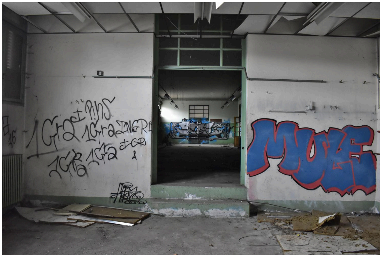
Étage de soubassement : enfilade des ateliers. [Photo chercheure.]
