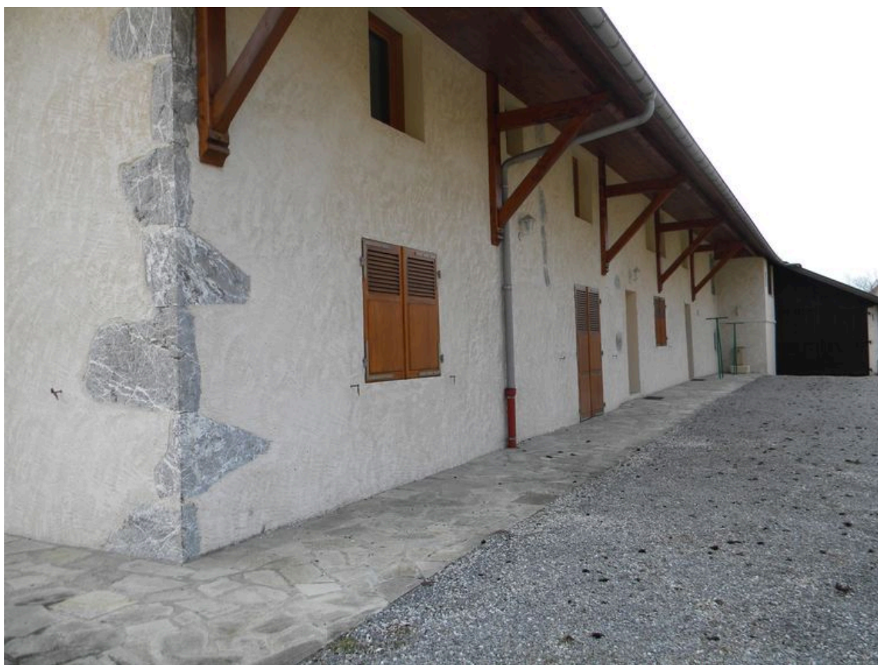
Vue de la façade arrière.
