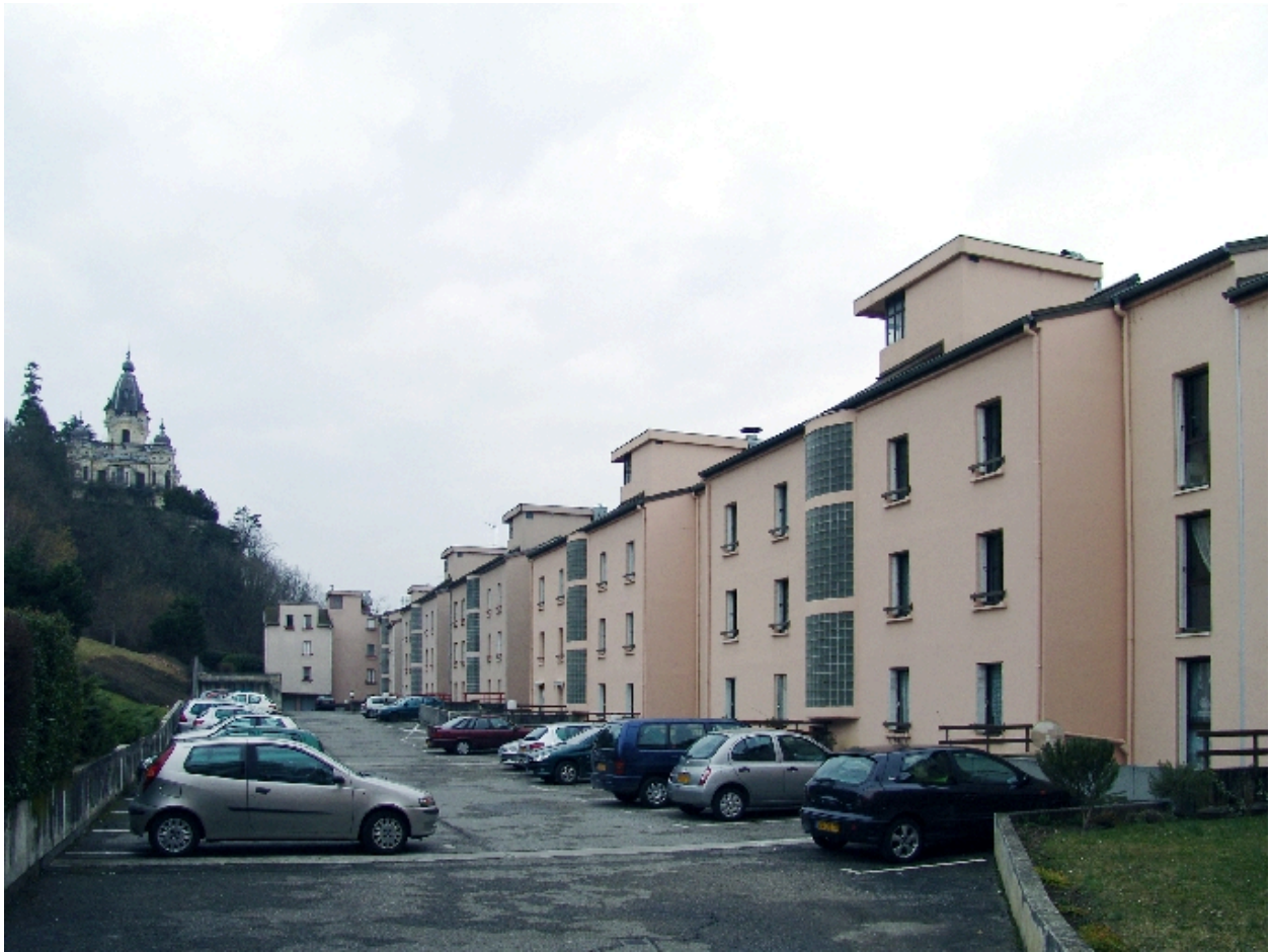
Façade postérieure vue de trois-quart
