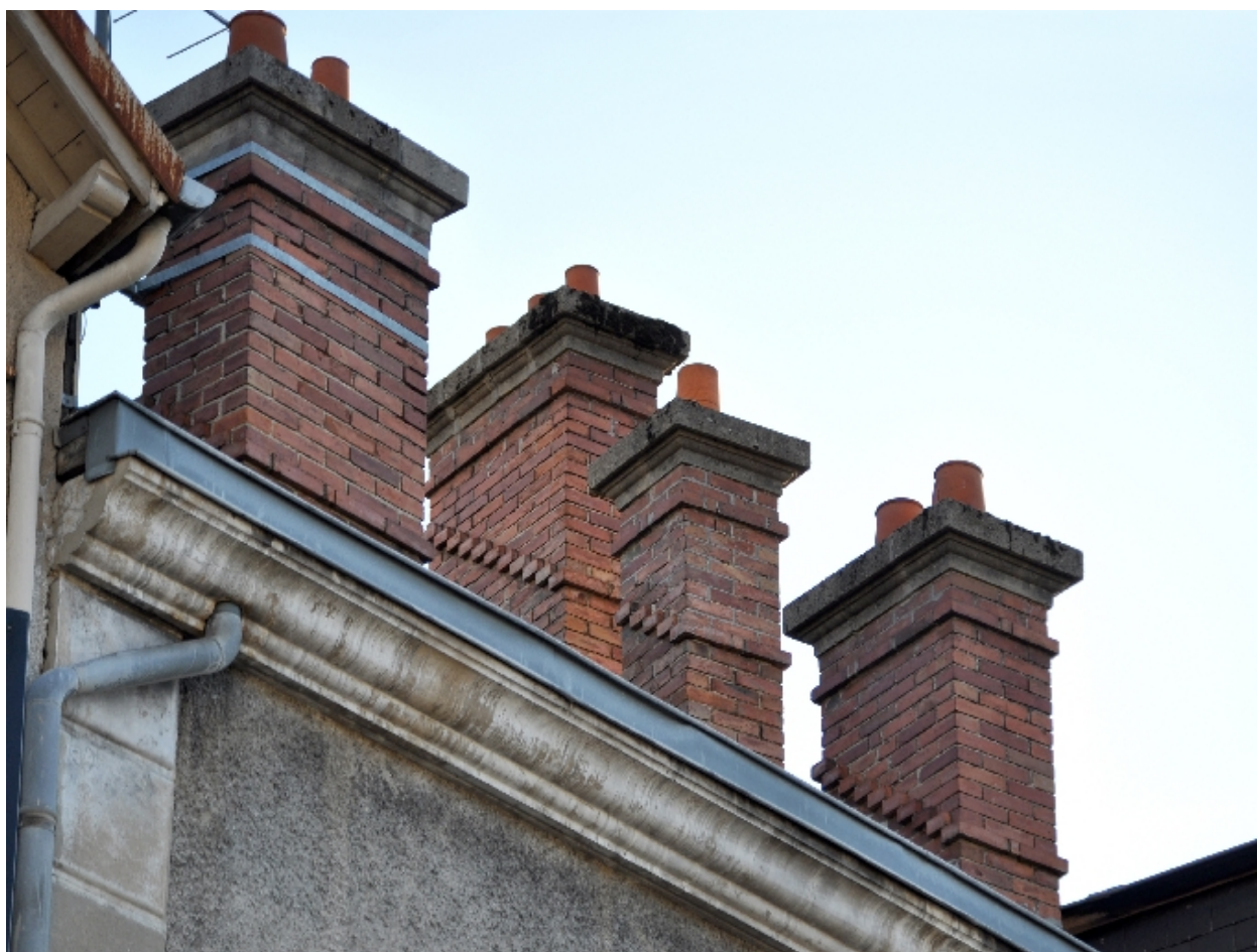
Détail de la corniche
