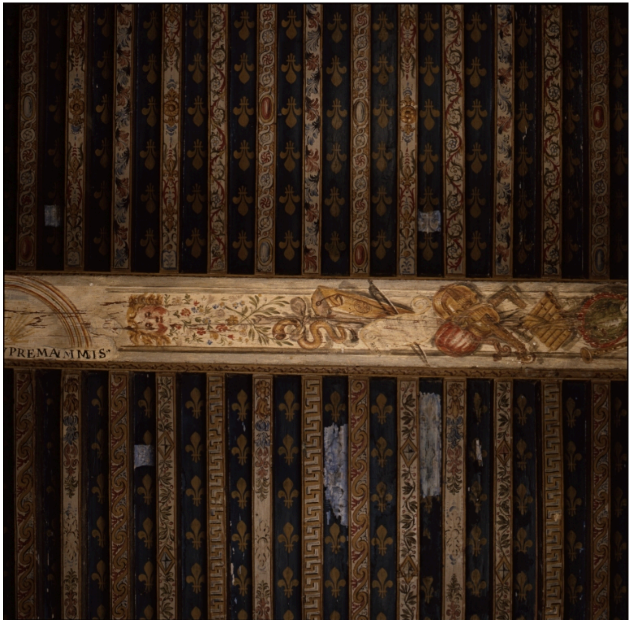
Poutre 4, face inférieure, centre droite, les Arts : la Musique.
