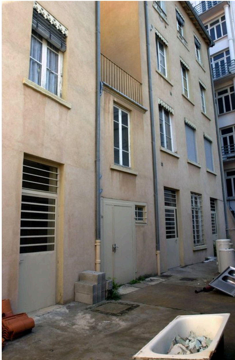
Elévation postérieure, vue partielle
