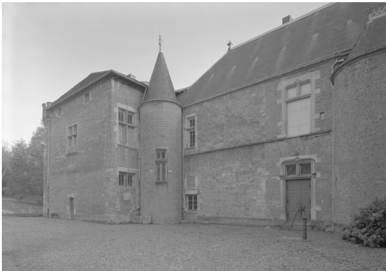
Aile sud, élévation sur cour.
