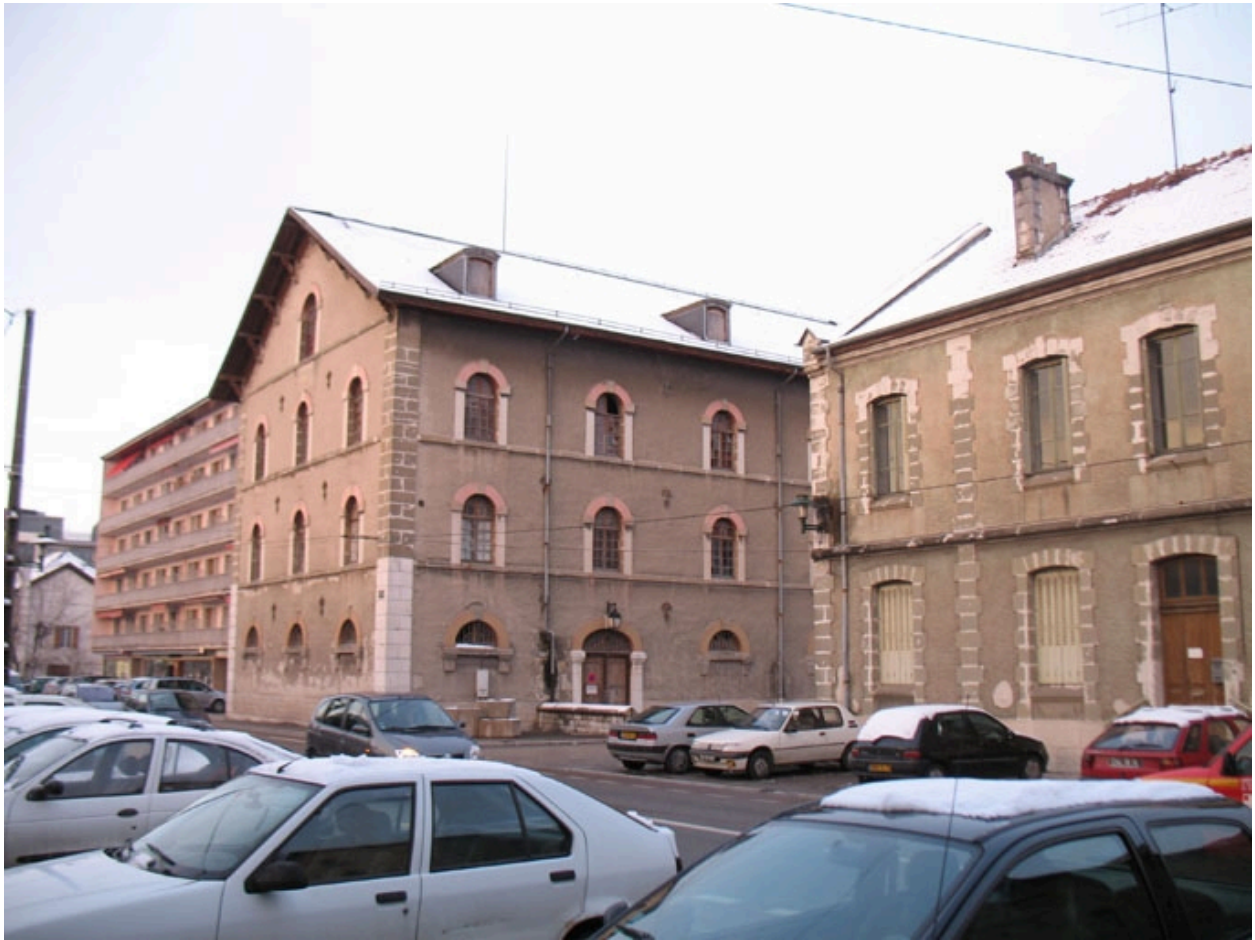
Vue d'ensemble sud-ouest de l'avenue Gantin
