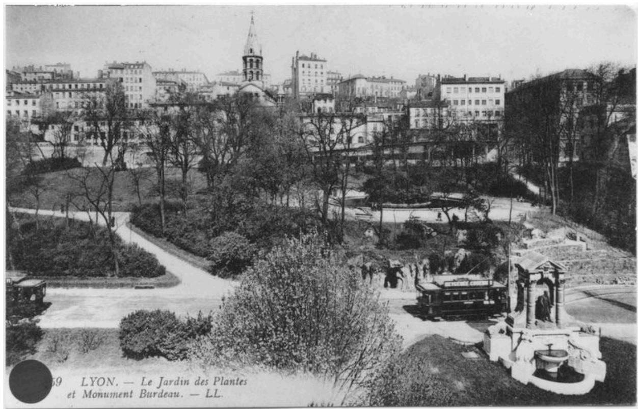
Vue de l'église du Bon Pasteur et du jardin des plantes au début du 20e siècle (Arch. mun. Lyon, 38 PH 191, n°216, carte postale).
