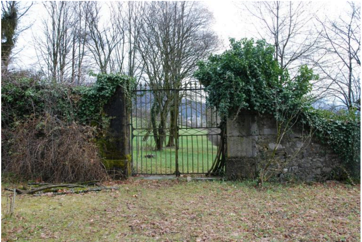
Grille de clôture du jardin situé au sud de la demeure.
