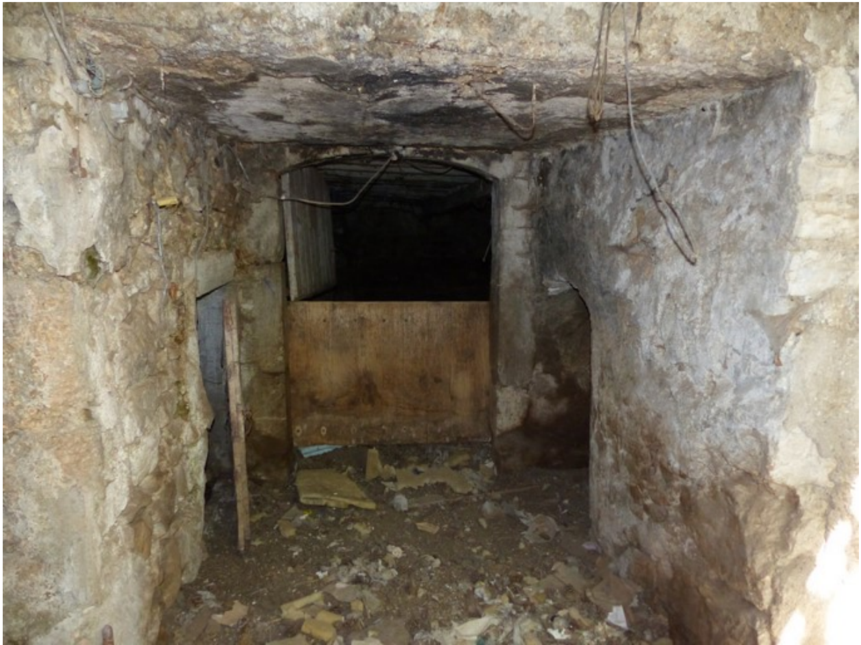
Partie ouest. Elévation sud, premier niveau. Pénétration sous le palier filant, vue de volume prise du sud.
