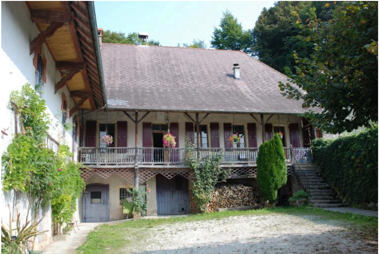
Vue d'ensemble de la façade sud du corps de logis sur cour.
