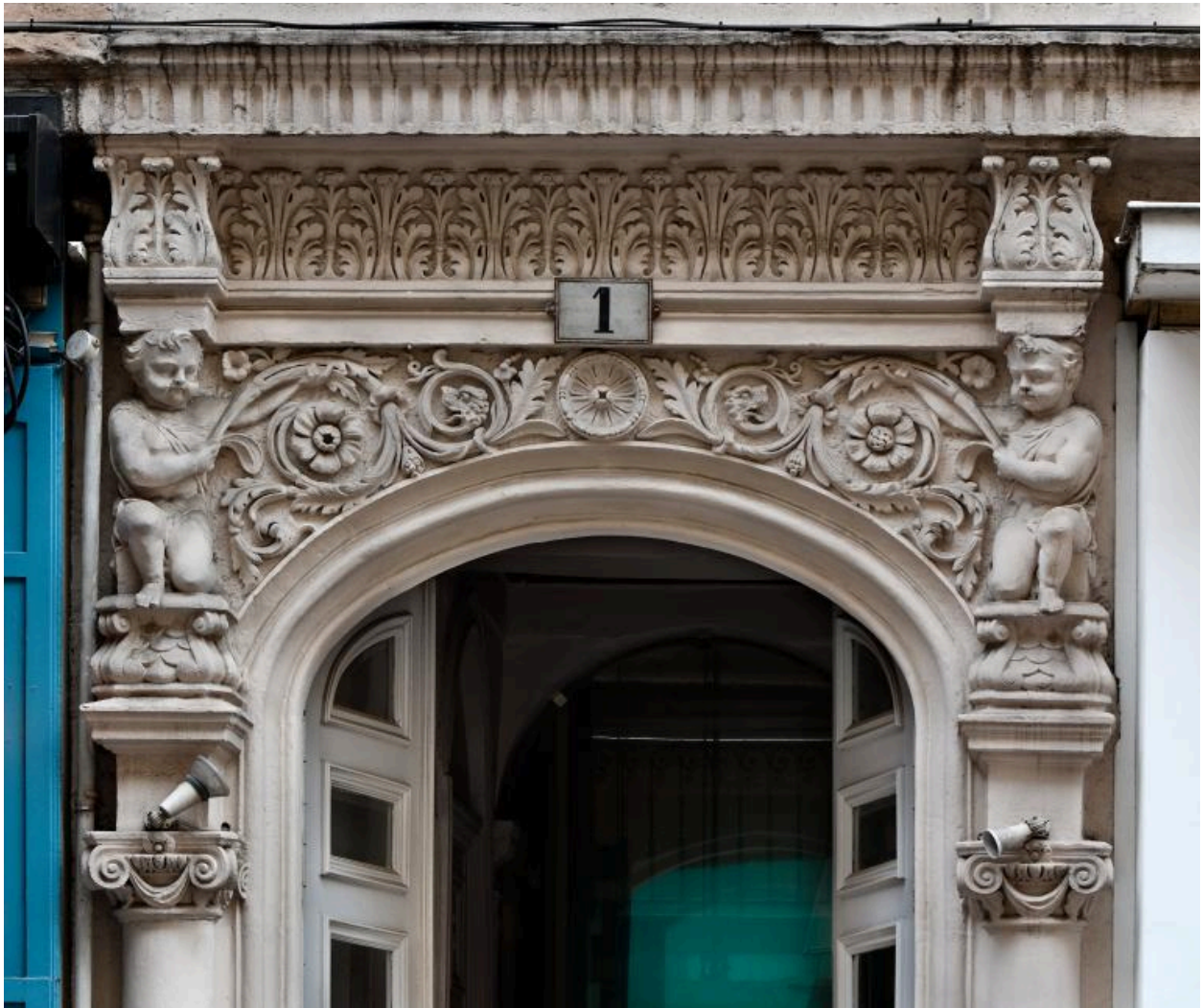
Rue Ferrandière : la porte bâtarde, détail de la partie supérieure
