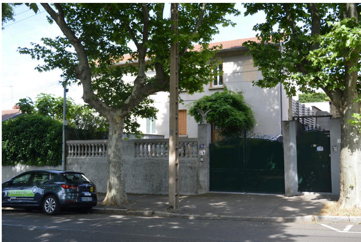
Maisons des cadres de l'ancienne usine Maréchal - boulevard Laurent Gérin - mai 2022
