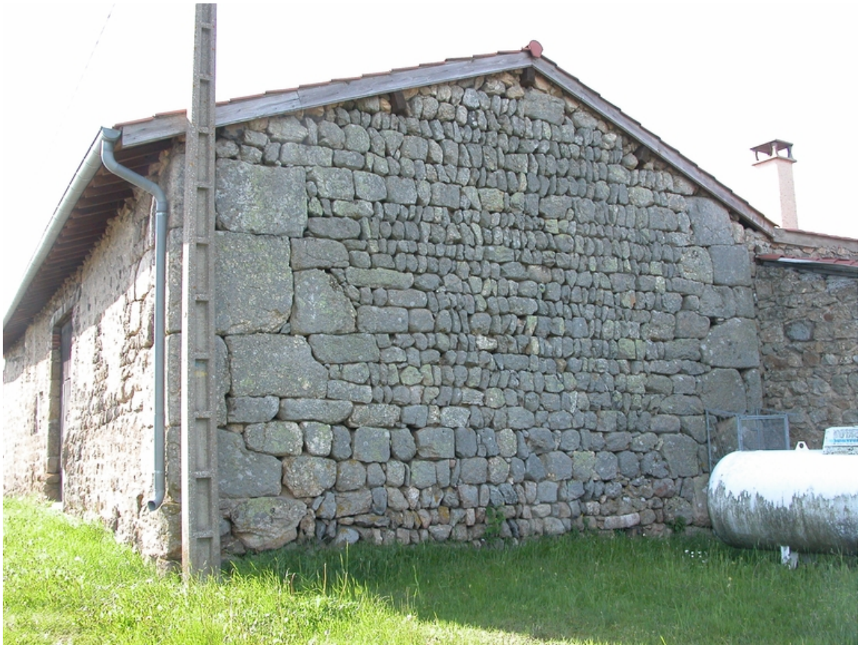
Mur pignon ouest de la grange-étable (moellon sur chant).
