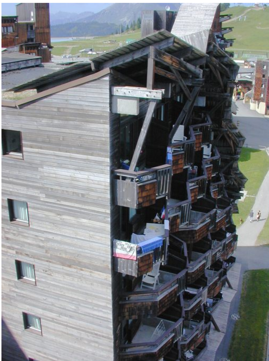
Vue d'ensemble du pignon sud et de la façade est
