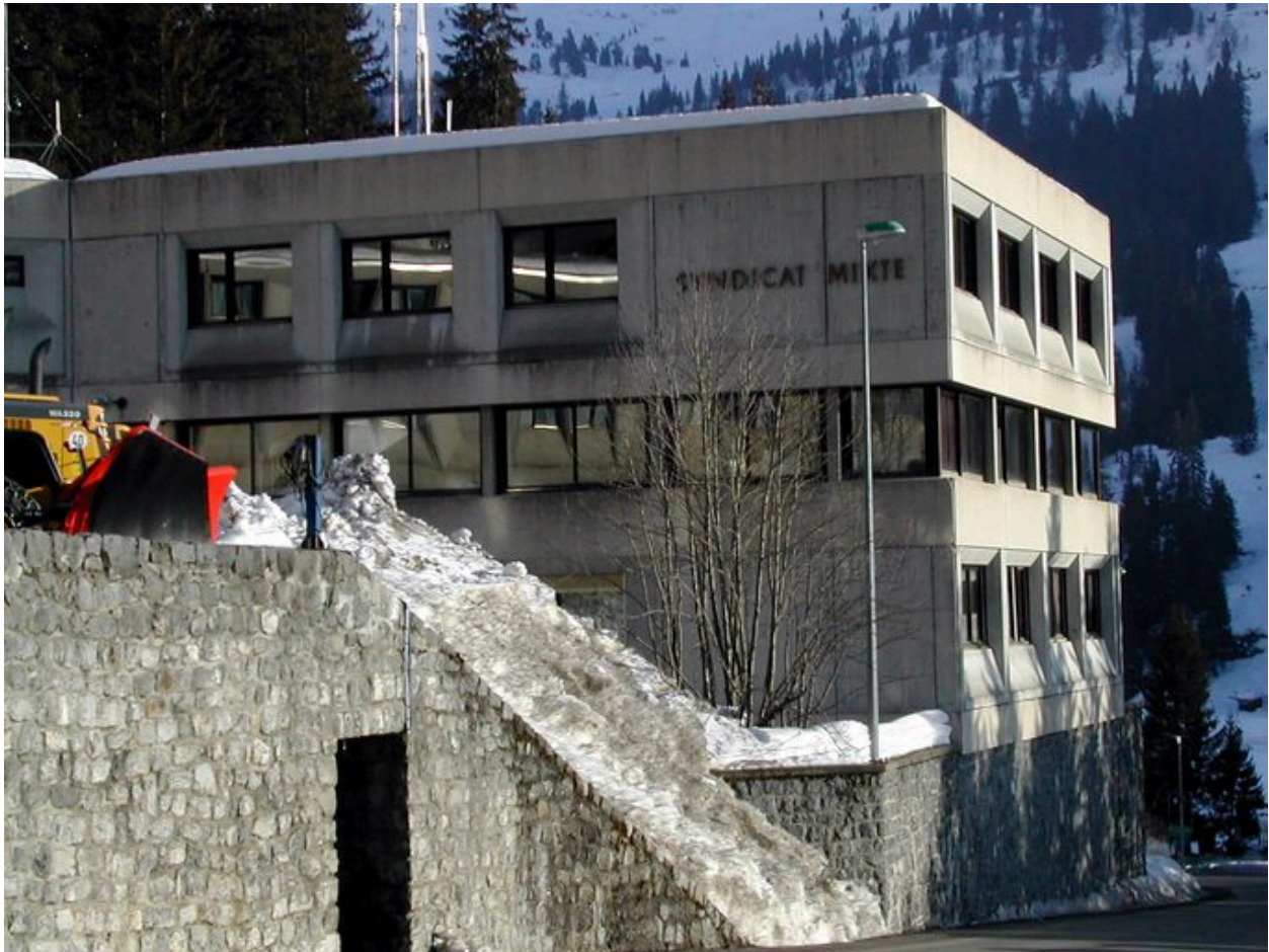
Le bâtiment du syndicat mixte depuis le nord-ouest
