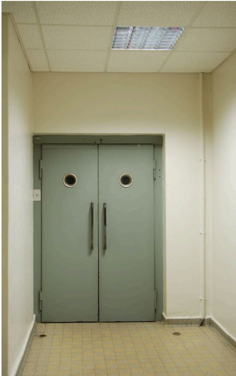
Bâtiment des services généraux, monte-charge, rez-de-chaussée du bâtiment des services généraux
