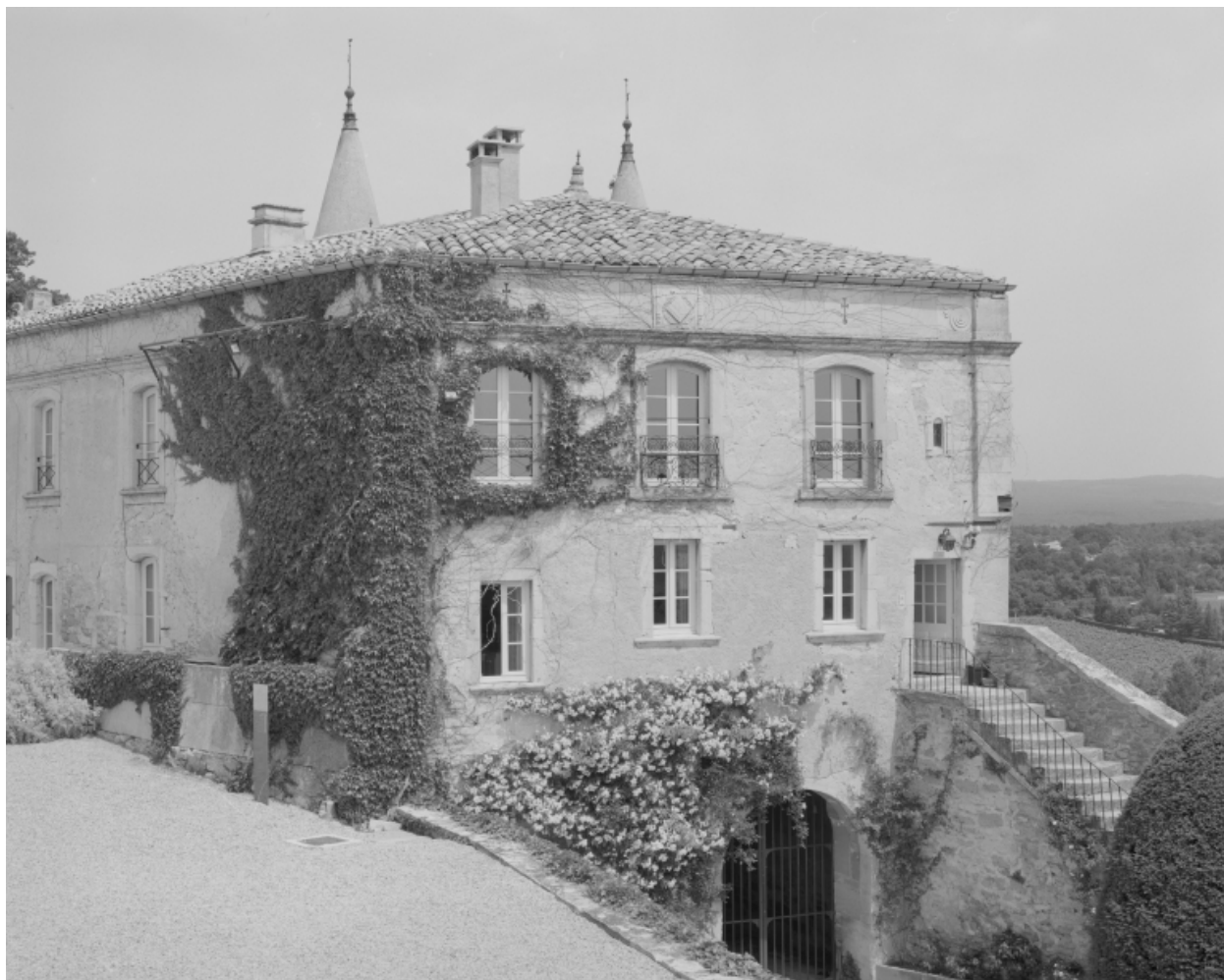
Bâtiment d'entrée. Vue de volume prise du sud-ouest.
