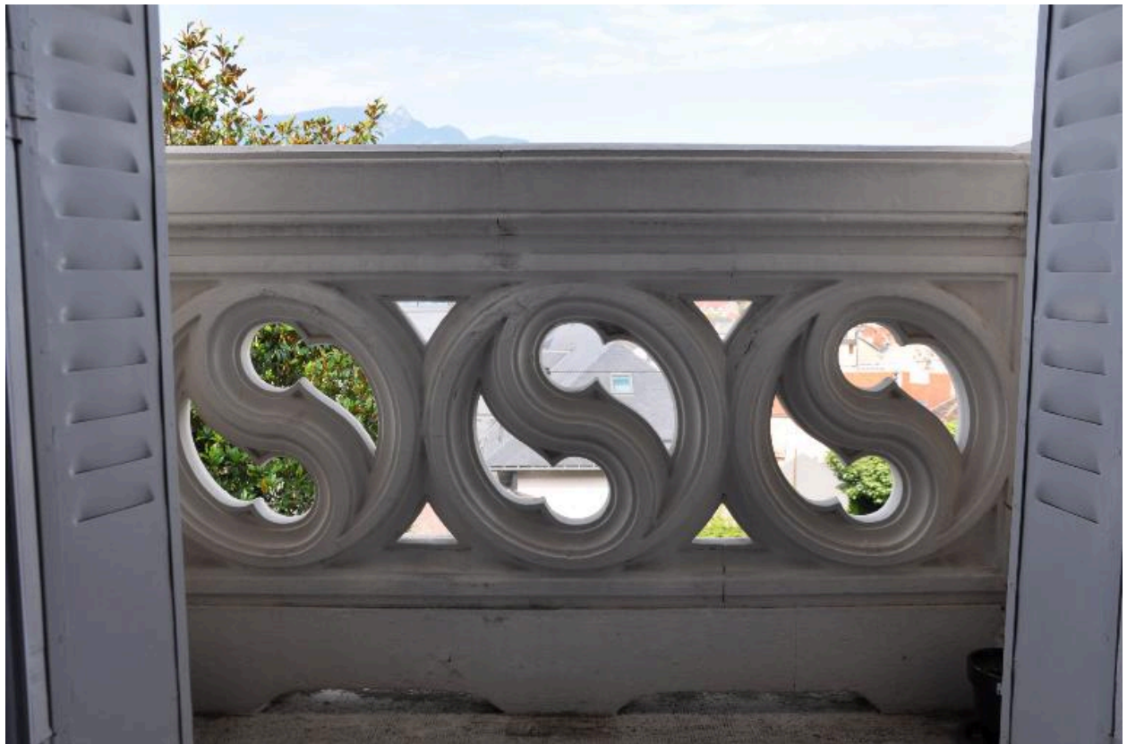
Les rosaces en ciment moulé du balcon vues depuis l'intérieur
