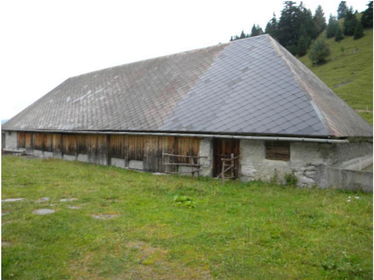
Vue de la façade principale de l'étable.
