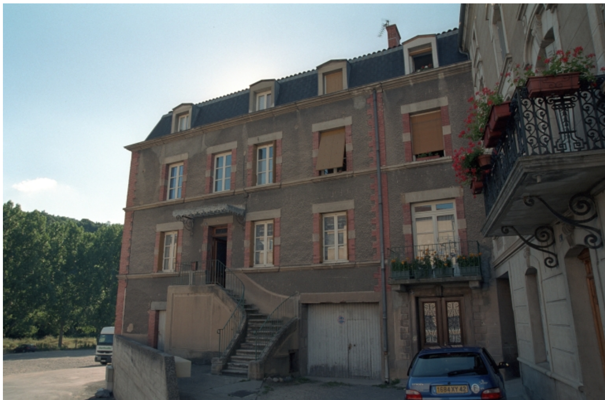
Boën, îlot 16, Gare (rue de la) 7, 9. Vue générale de la façade sur rue.
