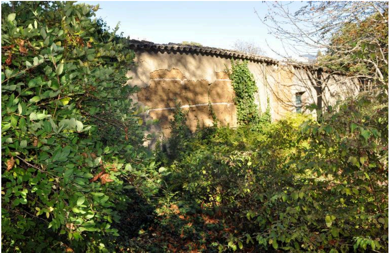
Mur de clôture ouest, en pisé enduit
