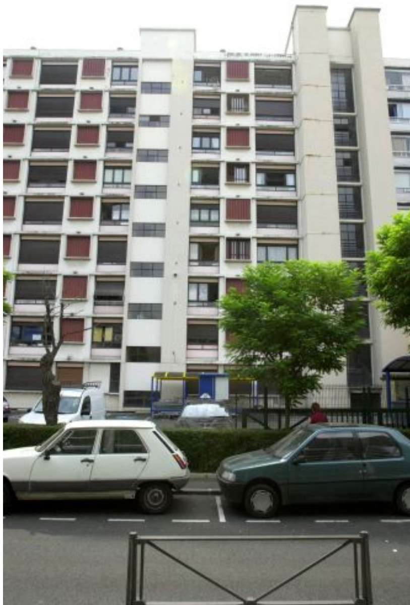
Elévation postérieure, vue d'un module
