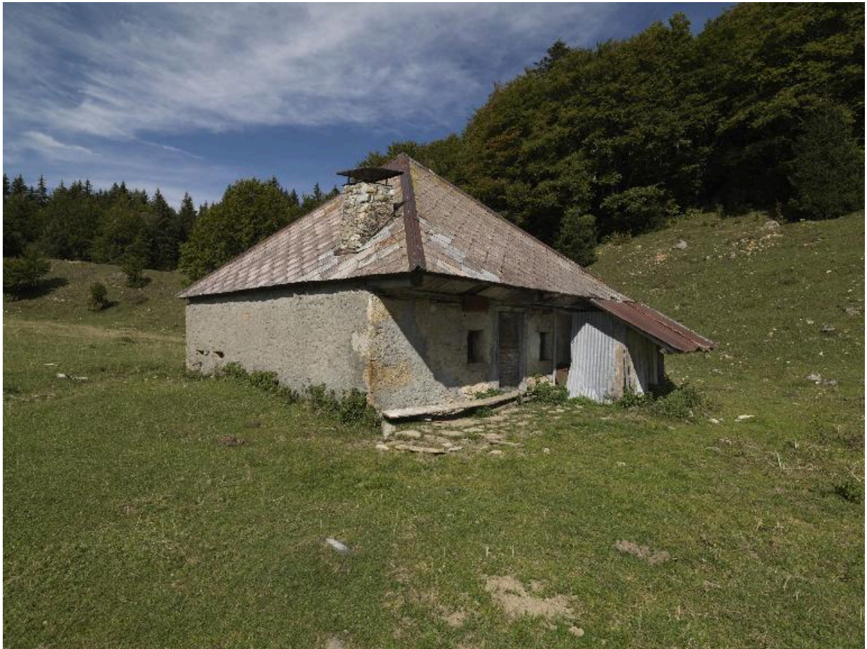
Vue du bâtiment d'habitation, façade principale.
