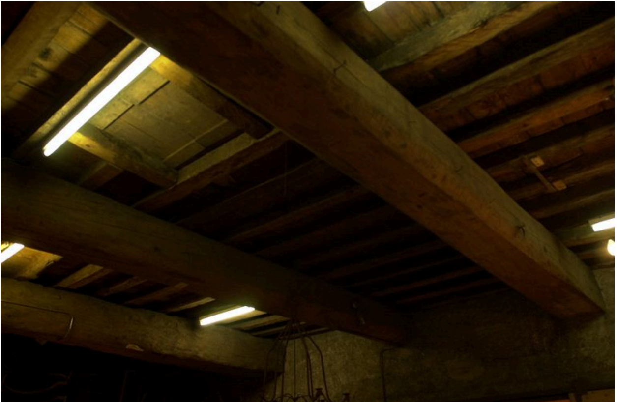
Vue du plafond à solives de l'ancien relais de poste
