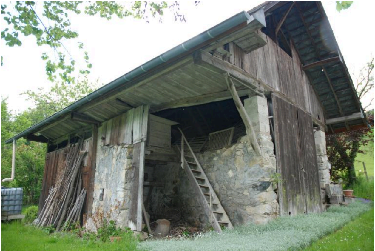
Vue du four à pain.
