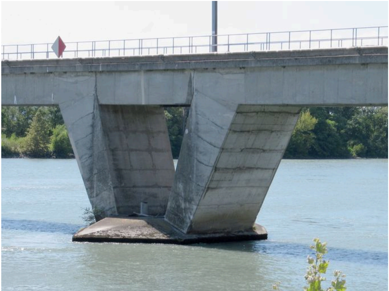
Pile, face amont, vue générale (depuis la rive droite)
