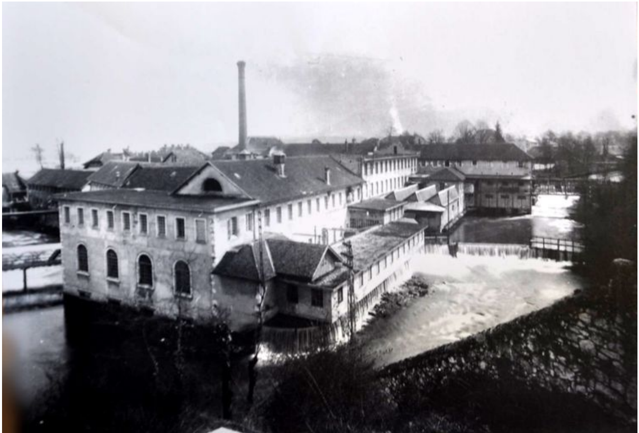
Vue des prises d'eau alimentant les ateliers de la Papeterie de Cran.1926.
