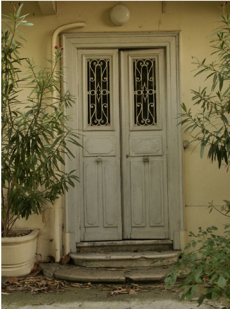
Porte de l'aile nord ouvrant sur le jardin
