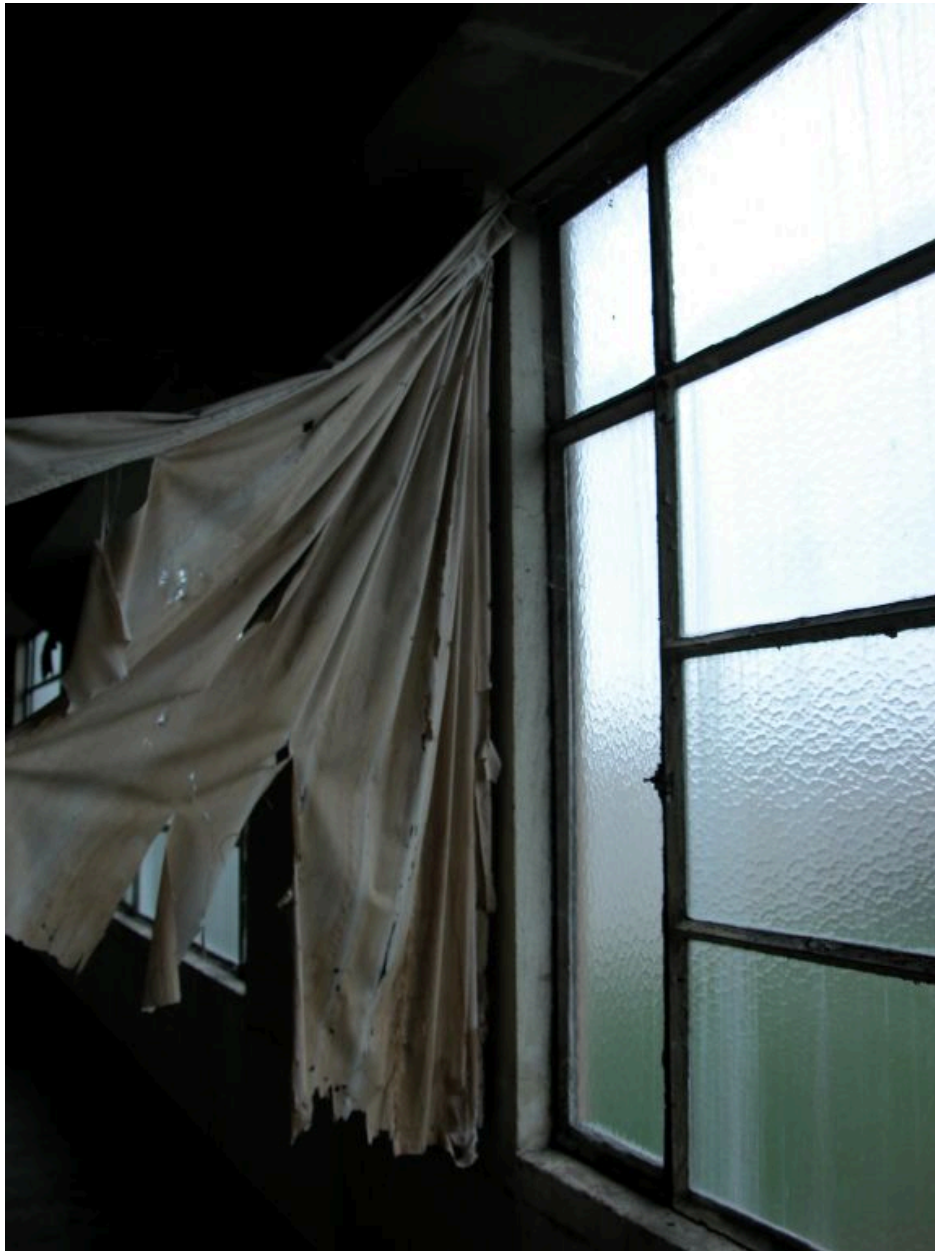
Détail d'une baie avec ancien store de l'aile nord de l'usine.
