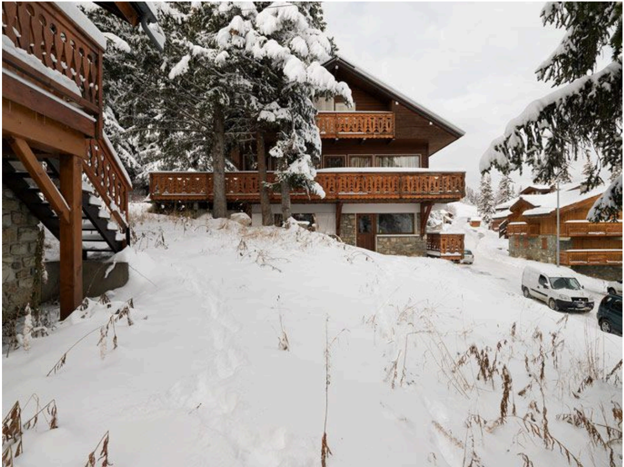
Vue générale depuis l'est
