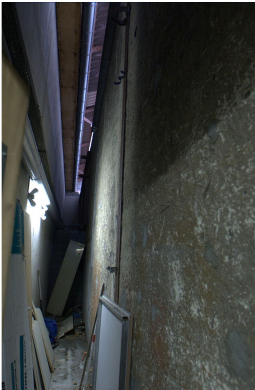
Zone tampon entre le nouveau aménagement du magasin et le bâtiment d'origine
