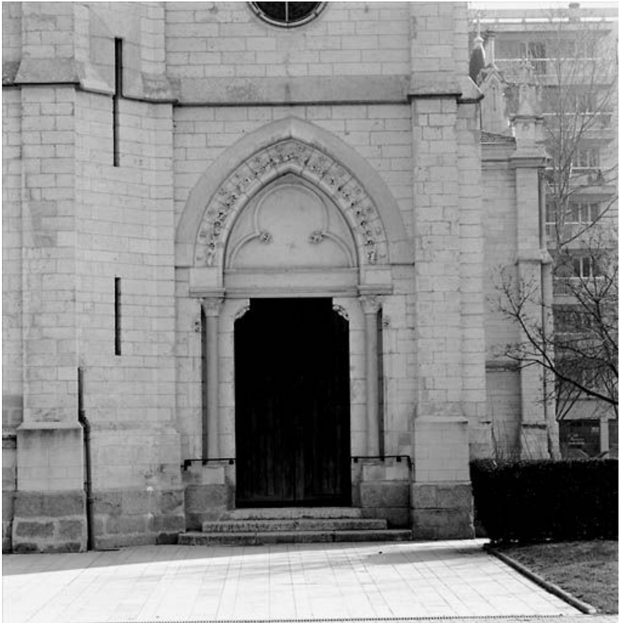
Élévation antérieure : le portail latéral sud
